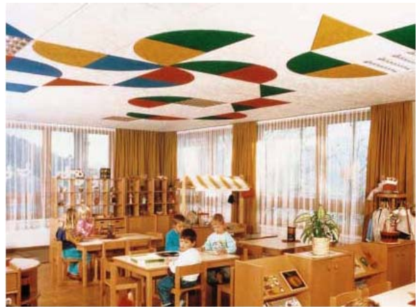
1. att. Fibrolīta plātņu pielietojums griestu konstrukcijās
