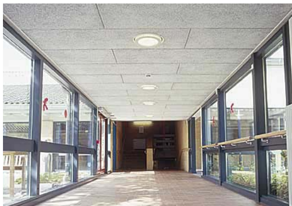
3. att. Gaismas ķermeņu izvietojums fibrolīta plātņu piekārtu griestu konstrukcijā
