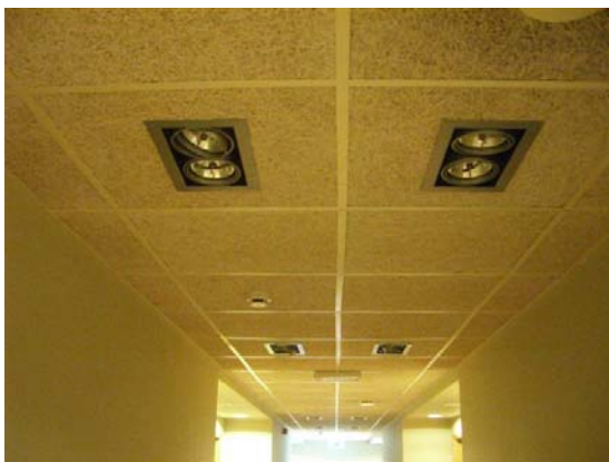
3. att. Gaismas ķermeņu izvietojums fibrolīta plātņu piekārtu griestu konstrukcijā
