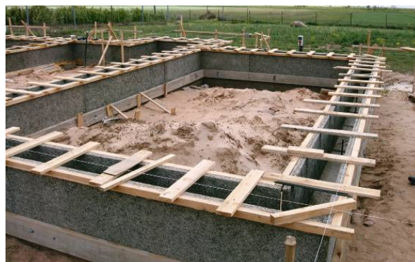
5. att. MBF sistēmā izbūvēti pamati
