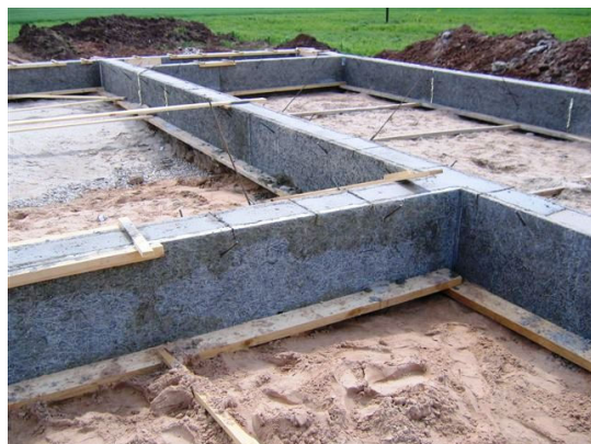
1. att. MBF sistēmā izbūvēti pamati
